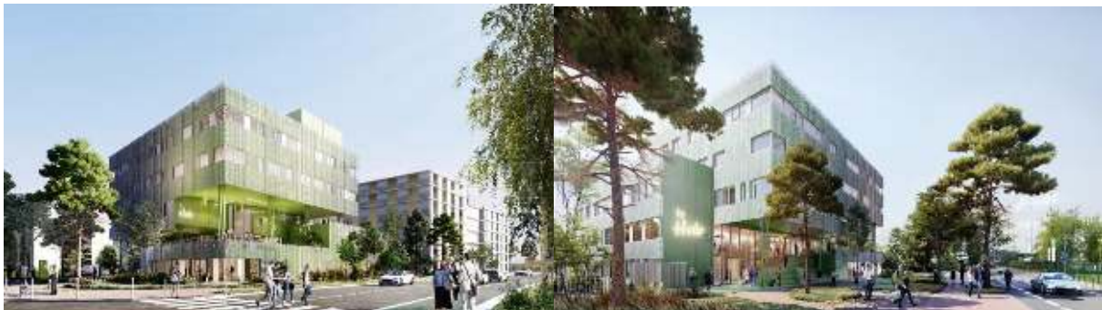
Vue de l'intersection de la rue du Professeur Jules Driessens et de l'avenue Eugène Avinée
